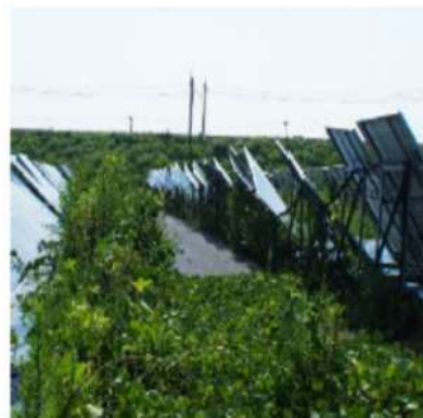
不十分な管理で放置されたパネル
