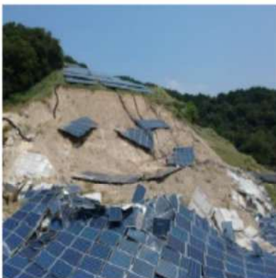
土砂崩れで生じた崩落
