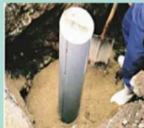
上下水道工事埋め戻し作業
