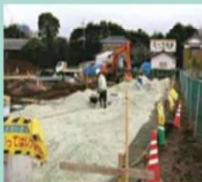
雨水流出抑制工事
