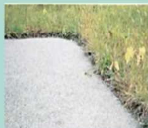
防草舗装表面
