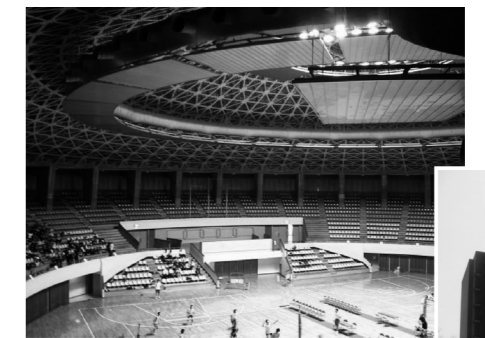
写真1 千葉県総合スポーツセンター (円錐形シェル内部)
