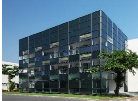
太陽光発電のビル壁面への設置
