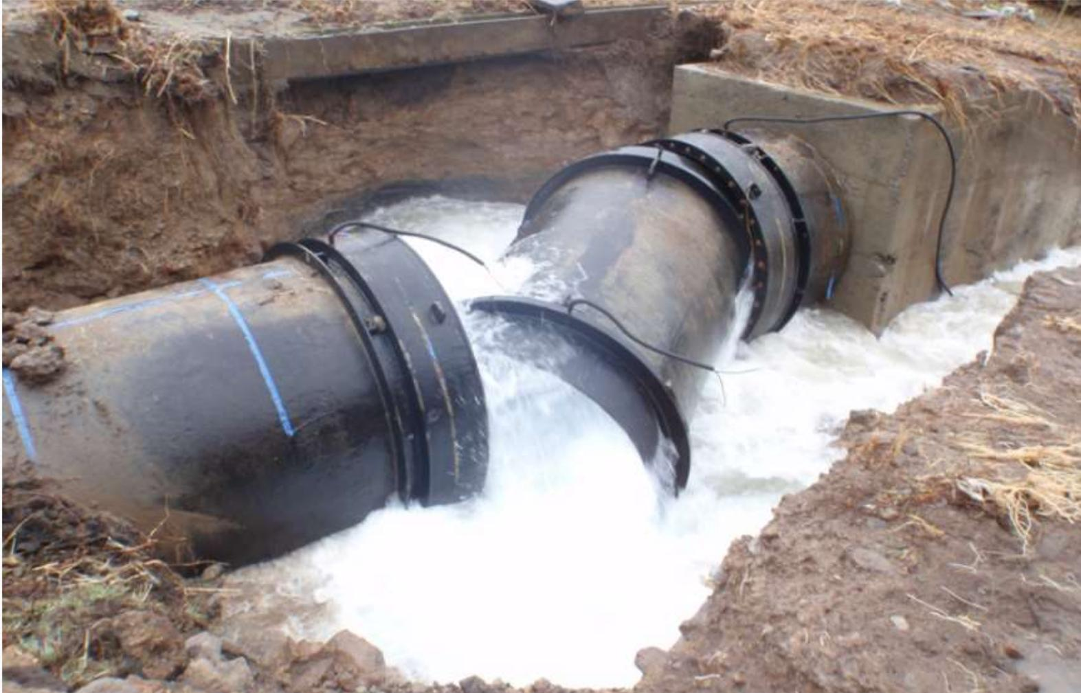
東日本大震災で被災した宮城県企業局送水管(口径2400mm)<sup>38</sup>
