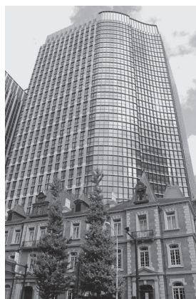
現事務所丸の内パークビル
